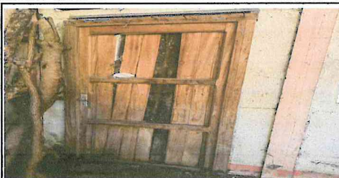
Foto 2: sustitución de puerta para el taller de usos multiples la cual es utilizada como cocina.
