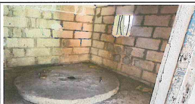
Foto 4: Sustitución de una puerta para proteger el cuidado del poso donde esta la bomba.
