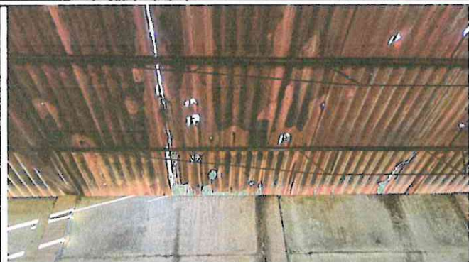
Foto1: arreglo de techado de taller de usos multiples la cual es utilizado para cocina.
