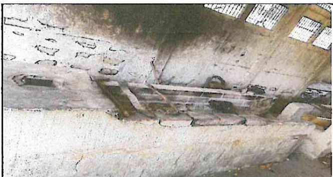
Foto 3: sustitución de hornillas para el uso de la cocina que esta en el area del taller de usos multiples.
